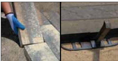
2. Lay Stones & Edge Restraint
